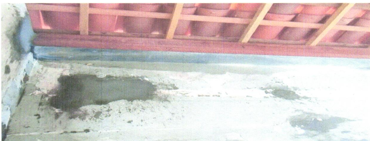
FOTO 09 – CALHA EM CHAPA DE AÇO GALVANIZADO NÚMERO 24, DESENVOLVIMENTO DE 33 CM, INCLUSO TRANSPORTE VERTICAL. AF_07/2019
