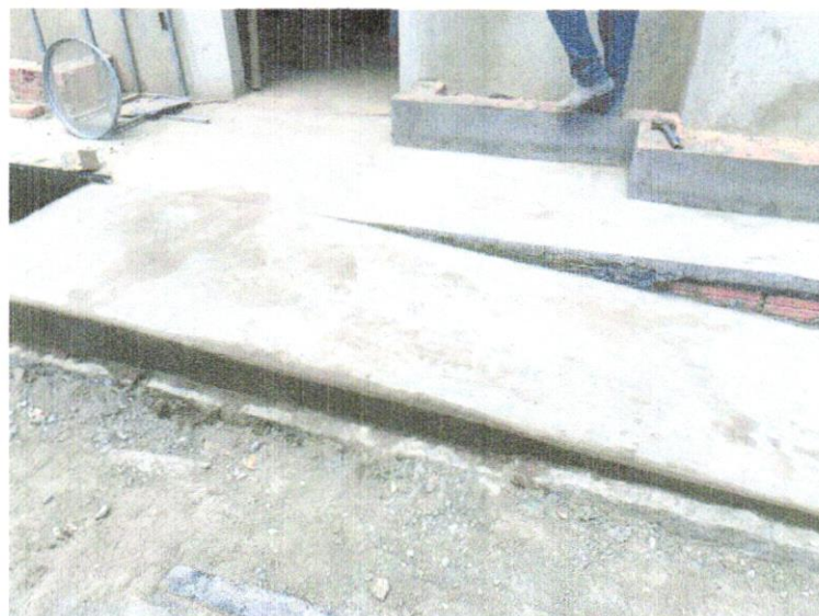
FOTO 06 – EXECUÇÃO DE PASSEI (CALÇADA) OU PISO DE CONCRETO COM CONCRETO MOLDADO IN LOCO, FEITO EM OBRA, ACABAMENTO CONVENCIONAL, ESPESSURA 8CM, ARMADO AF 07/216
