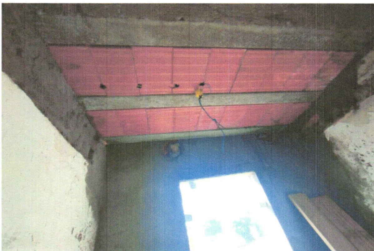
FOTO 07 - Laje pré-fabricada treliçada para piso ou cobertura, intereixo 38cm, h=12cm, el. enchimento em EPS h=8cm, inclusive escoramento em madeira e capeamento 4cm.2016
