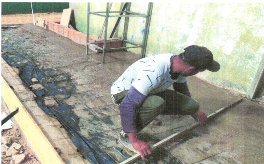
FOTO 13 - EXECUÇÃO DE PASSEIO (CALÇADA) OU PISO DE CONCRETO COM CONCRETO MOLDADO IN LOCO, FEITO EM OBRA, ACABAMENTO CONVENCIONAL, ESPESSURA 8 CM, ARMADO. AF_07/2016
